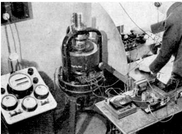
Die Frankesche Maschine als Tonfrequenz-Mess-generator im Labor. [6]
